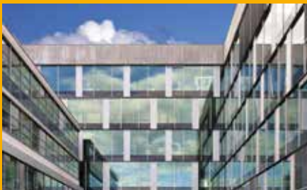
Kleben und Dichten im Fassadenbereich
