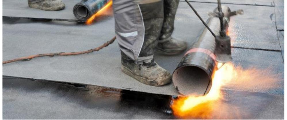
**Bitumenbahnen** in der **Balkonabdichtung** werden entweder **ein- bzw. zweilagig verlegt** (abhängig von der Nutzungskategorie). Bei der 2-Lagigkeit werden die Einzel-lagen **vollflächig** miteinander **verschweißt**.
