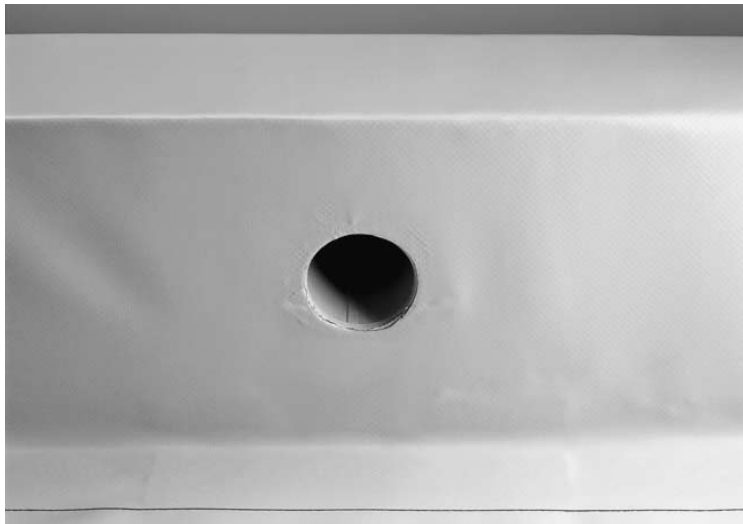
Fertiger Notüberlauf
