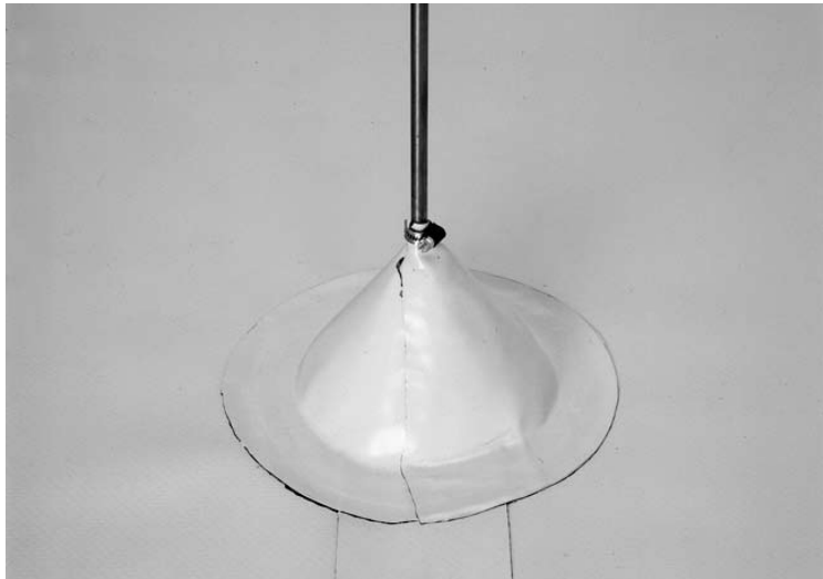
Fertiger Blitzschutz mit Klemmbride
