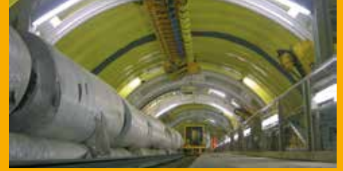
TUNNELBAU UND BAUWERKSABDICHTUNG
