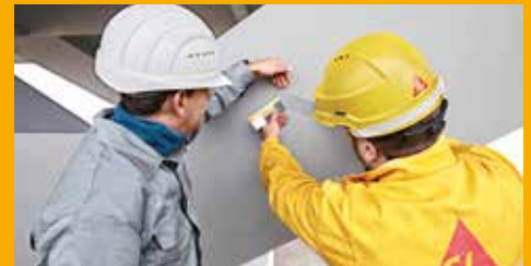
SERVICE UND BERATUNG AUF DER BAUSTELLE
