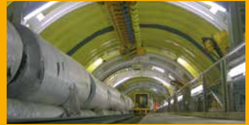
TUNNELBAU UND BAUWERKSABDICHTUNG
