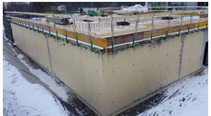
Beim SikaProof® A+ pre-applied sind die Ankerlöcher im Nachgang abzudichten
