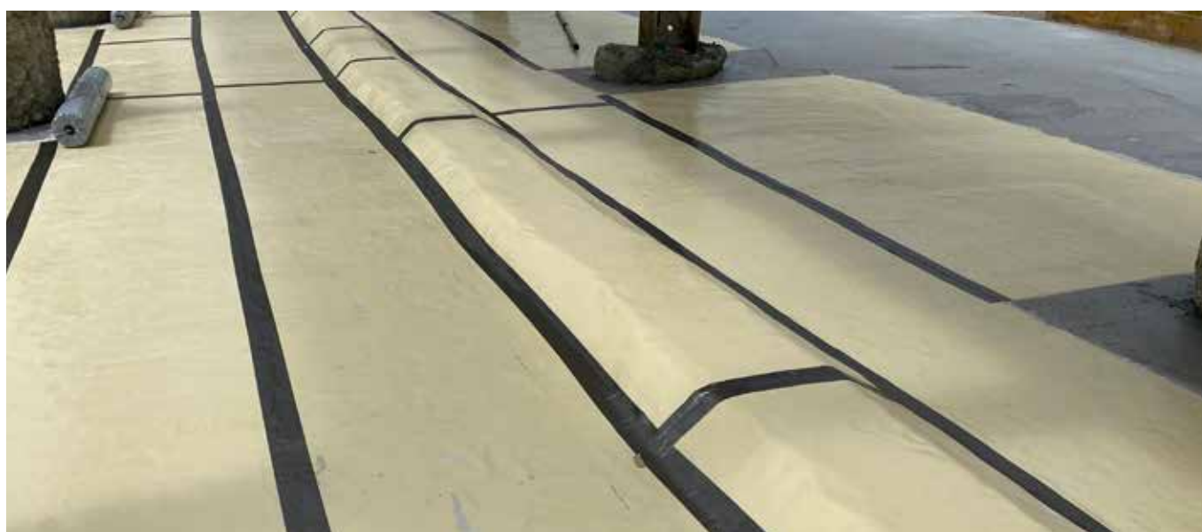
SikaProof® A+ post-applied als horizontale Abdichtung eines Tagbautunneldeckels
