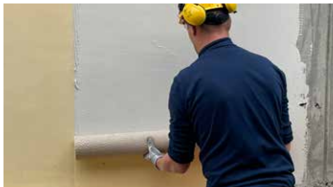
Einbetten der SikaProof® A+ Membran in den Systemklebstoff
