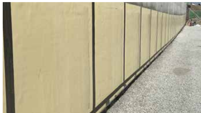
Beim SikaProof® A+ post-applied werden die Ankerlöcher in einem Arbeitsgang abgedichtet
