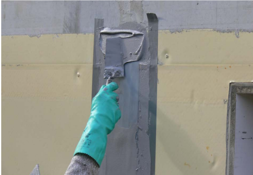
Abdichtung von Arbeitsfugen bei Fertigteilmwänden mit Sikadur-Combiflex
