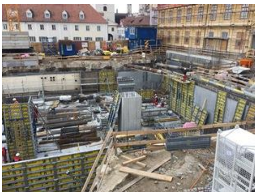
Verlegung der Wandflächen inkl. Einbindung der Durchdringungen mit Frischbetonverbundsystem SikaProof® A im April 2017
