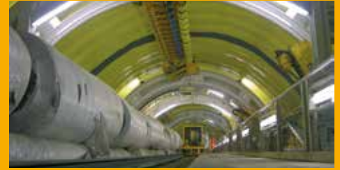
TUNNELBAU UND BAUWERKSABDICHTUNG
