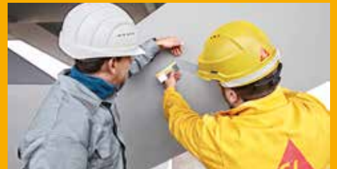
SERVICE UND BERATUNG AUF DER BAUSTELLE
