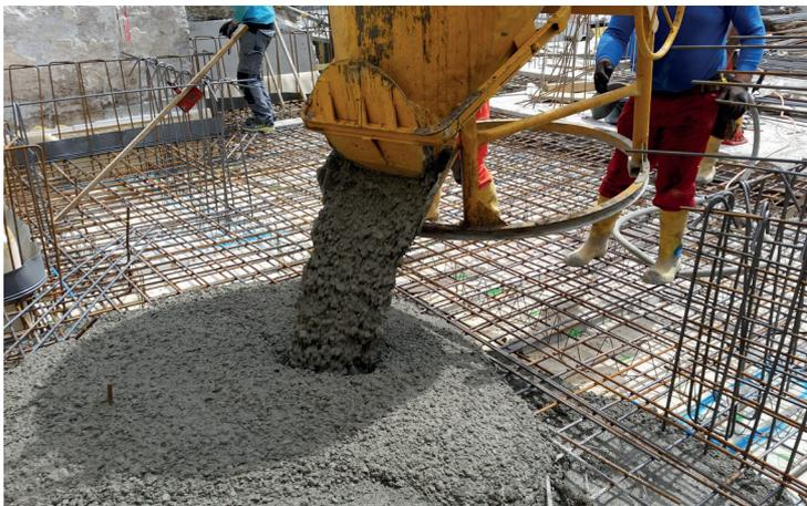
Bild 3 - Einbringen des Betons
