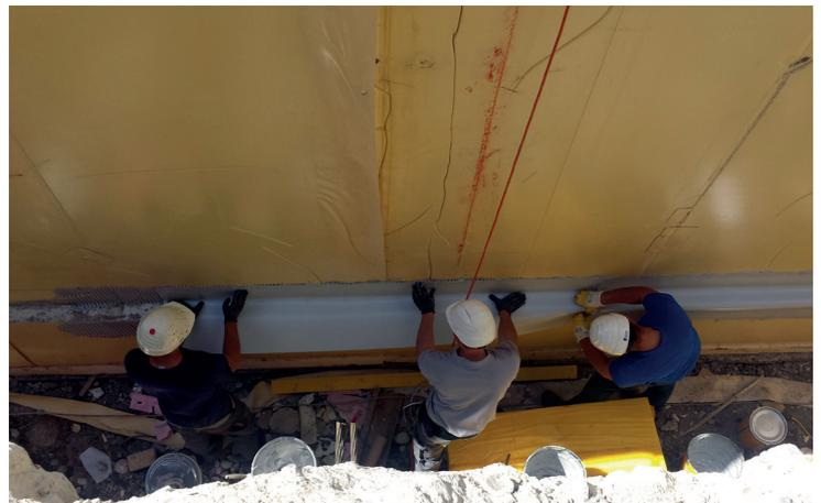
Bild 4 - Abdichtung des Bodenplattenüberstandes mit dem Combiflexsystem
