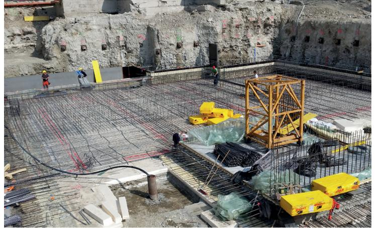
Bild 2 - Bewehrungsarbeiten auf der Frischbetonverbundfolie
