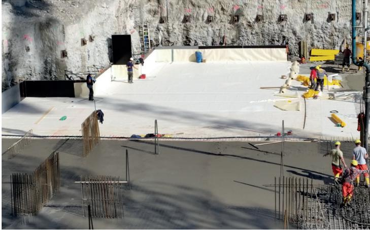
Bild 1 - Verlegung von SikaProof A auf der Wärmedämmung
