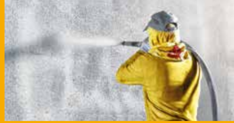
BETONSCHUTZ UND INSTANDHALTUNG
