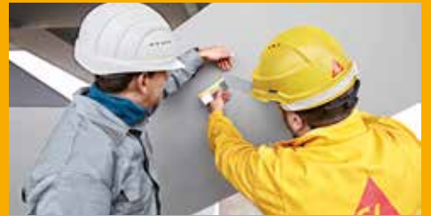
SERVICE UND BERATUNG AUF DER BAUSTELLE
