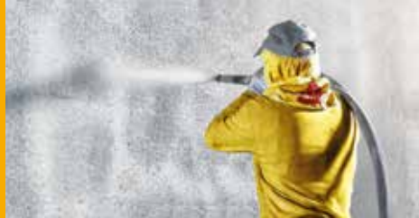
BETONSCHUTZ UND INSTANDHALTUNG
