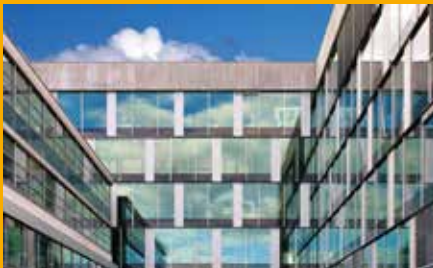
Kleben und Dichten im Fassadenbereich
