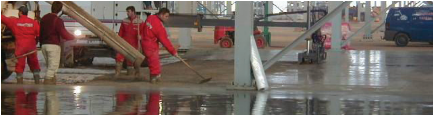
VERBUNDBETON: Mindeststärke 6 cm VERBUNDESTRICH: Mindeststärke 6 cm KUNSTSTOFFVERGÜTETER VERBUNDESTRICH: Hartbetonüberzug ca. 2-3 cm
