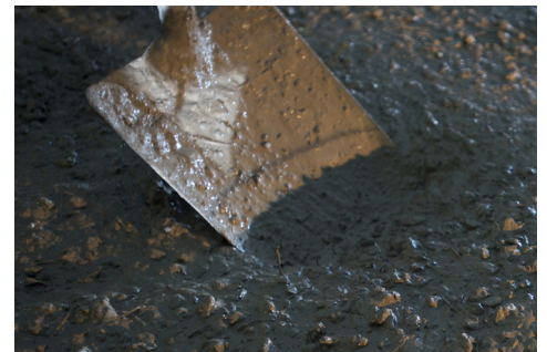
VERBUNDBETON: Mindeststärke 6 cm VERBUNDESTRICH: Mindeststärke 6 cm KUNSTSTOFFVERGÜTETER VERBUNDESTRICH: Hartbetonüberzug ca. 2-3 cm
