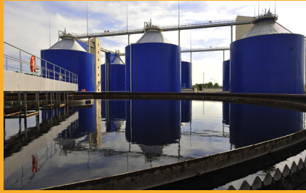
Schutz und Instandsetzung von Beton
