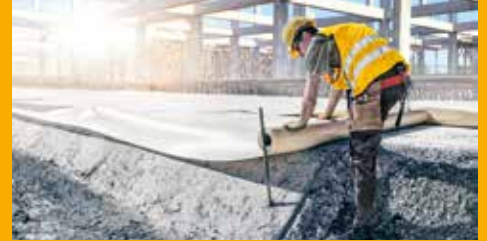
TUNNELBAU UND BAUWERKSABDICHTUNG
