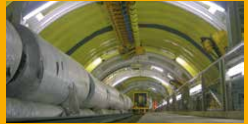
TUNNELBAU UND BAUWERKSABDICHTUNG
