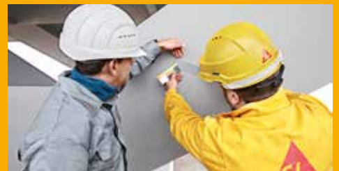
SERVICE UND BERATUNG AUF DER BAUSTELLE
