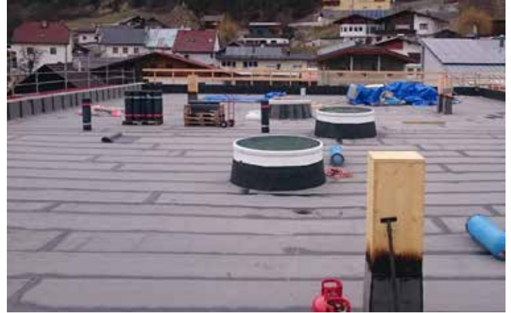
Bild 2: Unter dem Gründachaufbau befindet sich die Bitumen-Dachabdichtung
