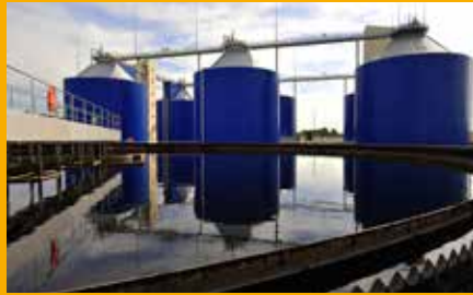
Schutz und Instandsetzung von Beton
