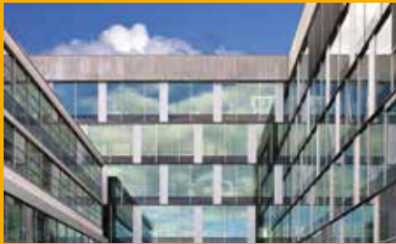
Kleben und Dichten im Fassadenbereich
