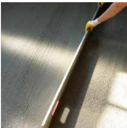
Einbau SikaScreed® HardTop
