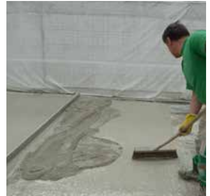
Auftragen der Haftbrücke
