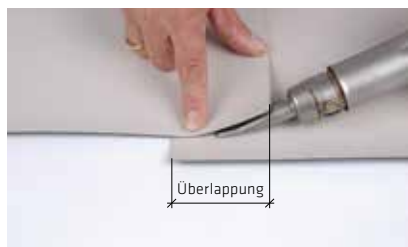
1. Heftung der sauberen und trockenen Überlappung
