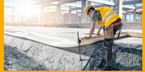
TUNNELBAU UND BAUWERKSABDICHTUNG
