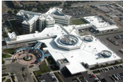
Cool Roofs mit hoher Reflection
