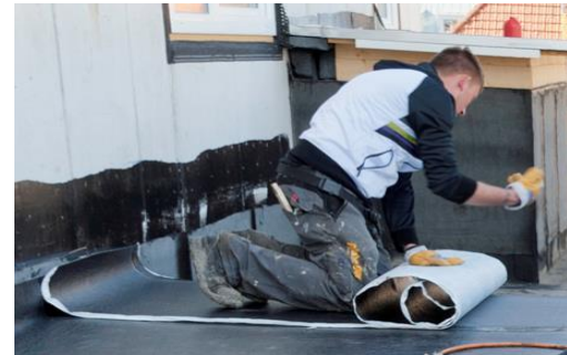
Selbstklebeverfahren (Abziehfolie)
