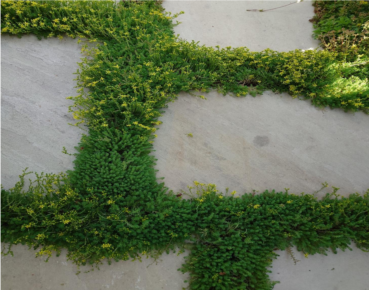
Plattenbelag mit Sedumfugen
