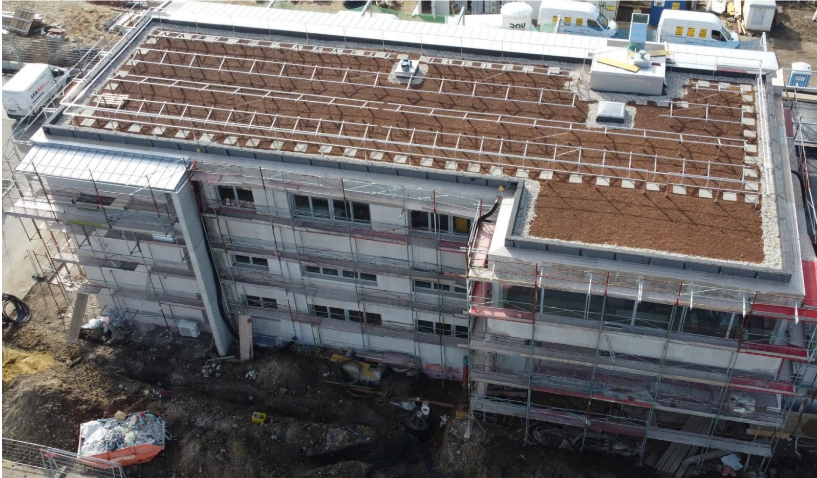
Ballastierung von Solar FKD durch Extensivsubstrat
