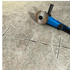
1. Rissflanken aufweiten und alle 20 cm quer einfräsen.
