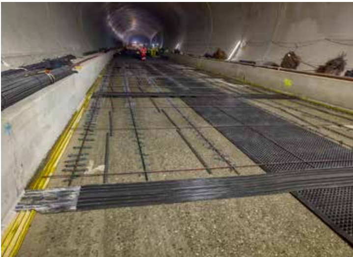
Bild 4: Längslaufendes Fugenband Sika Waterbar® WP AF-320 und querlaufendes Blockfugenband Sika Waterbar® WP AF-500
