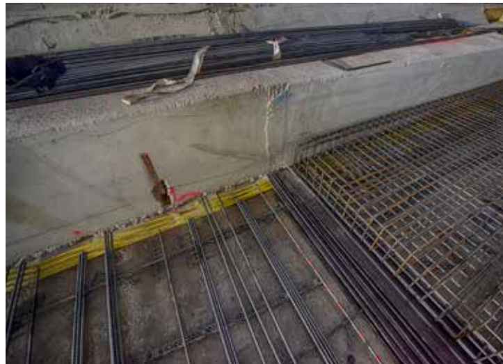
Bild 5: Halbseitig eingebundenes Fugenband Sika Waterbar® WP AF-320 und querlaufendes Blockfugenband Sika Waterbar® WP AF-500
