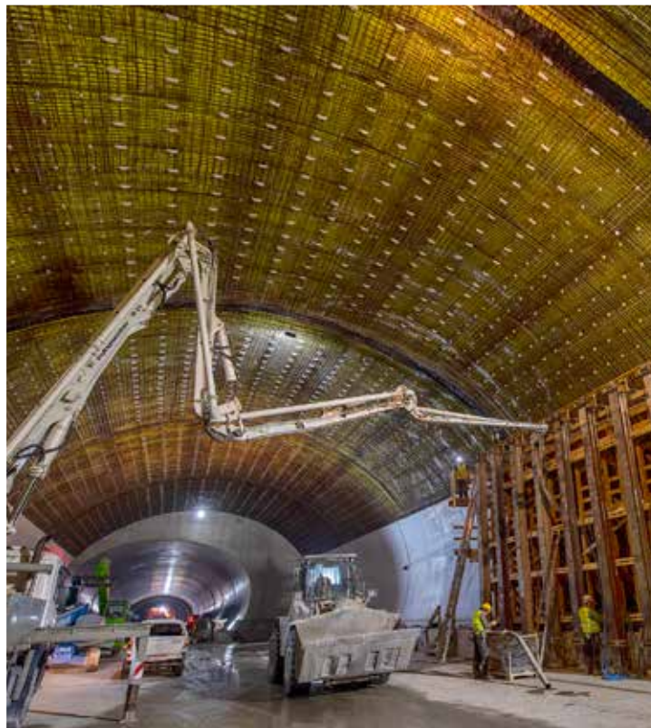
Bild 9: Bauarbeiten in der Kaverne Aldrans
