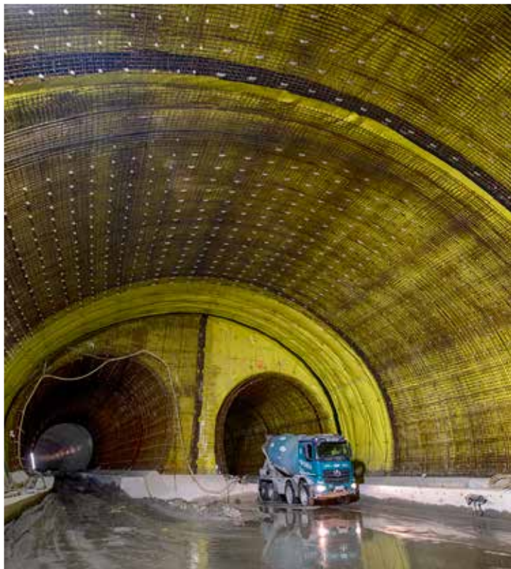
Bild 8: Zugang zu den Verbindungstunneln Ost und West
