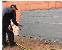
PCI Barraseal® Turbo für die Socketabdichtung (Außen)
