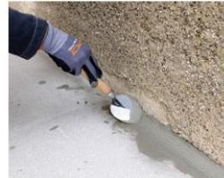
PCI Poly fix® plus L für Dichte- / Hohlkehle
