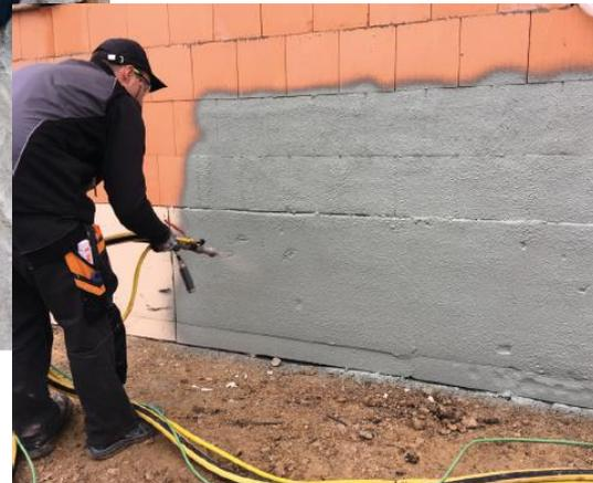
PCI Barraseal® Turbo für die Sockelabdichtung (Außen)
