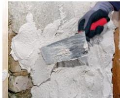
PCI Saniment® 2in1 kombiniert Sanier- & Feinputz in einem
