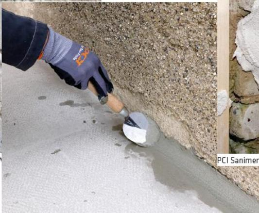
PCI Polyfix® plus L für Dicht-/ Hohlkehle
