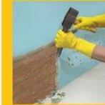
Entfernen Sie alte Anstriche, lösen Pitz, Schmutz, Staub etc. um das Mauerwerk freizulegen.
