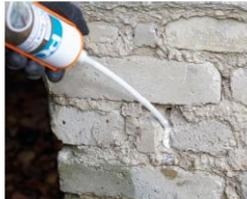
PCI Barra® Creme für Injektion einer wasserabweisenden Horizontalsperre
