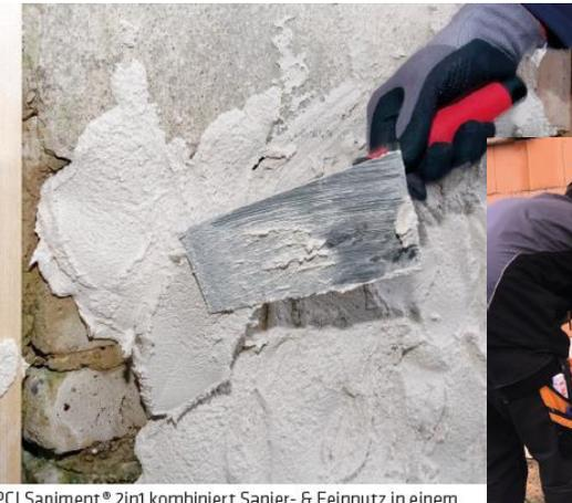
PCI Saniment® 2in1 kombiniert Sanier- & Feinputz in einem
