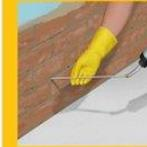
Führen Sie den beigefügten Injektionsschlauch in die Löcher ein und füllen Sie die Löcher komplett mit SikaMur InjectoCream-100.
