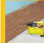
Bohren Sie Löcher mit einem Durchmesser von 10-12 mm direkt in die Fuge. Die Tiefe so wählen, dass ca. 20mm Mauerwerk bei der Bohrung übrig bleiben. Der Abstand zwischen den Löchern sollte ca. 12cm sein.
