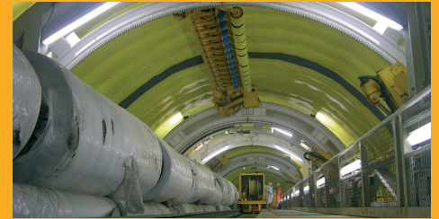
TUNNELBAU UND BAUWERKSABDICHTUNG
