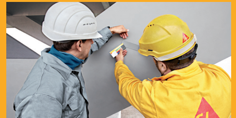
SERVICE UND BERATUNG AUF DER BAUSTELLE
