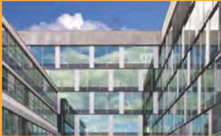
Kleben und Dichten im Fassadenbereich
