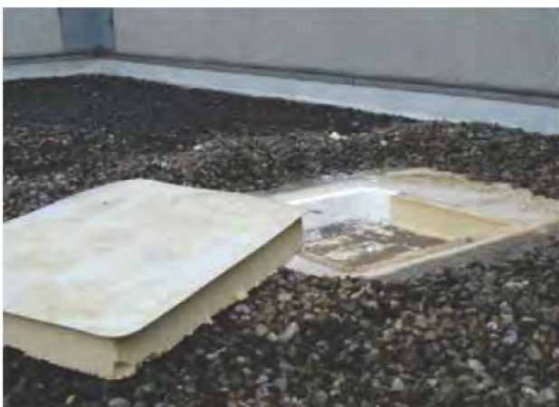
Dachaufbau komplett trocken
