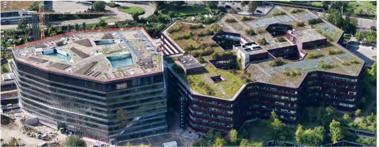
Rechts: über 20-jähriges Sarnafil-Dach | Links: neues Sarnafil-Dach
