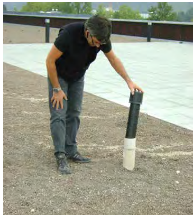
Kontrollrohre gewährleisten jederzeit einen Einblick in den Dachaufbau und lassen Infiltrationen frühzeitig erkennen.
