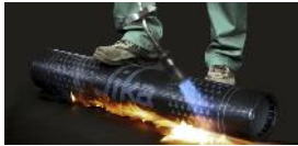
Abdichtung: Flächen, Risse, Fugen
