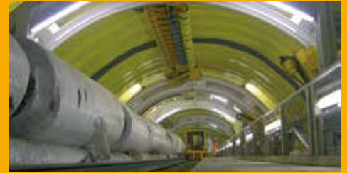
TUNNELBAU UND BAUWERKSABDICHTUNG
