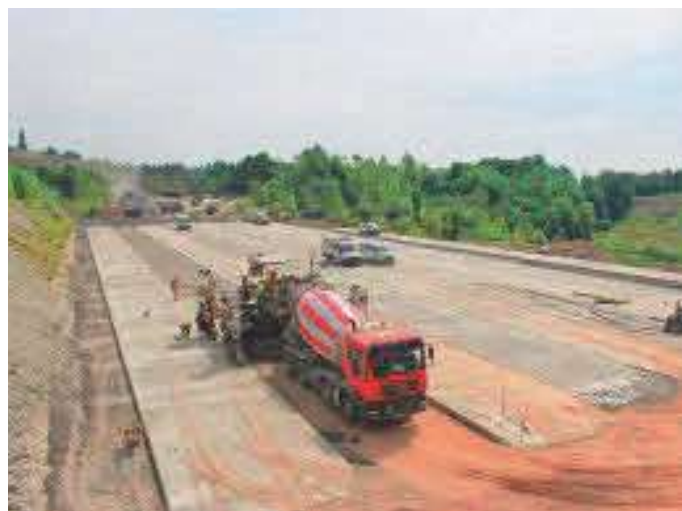
Alternativen im Bereich Asphaltanierung werden beim Teststreckenabschnitt Retznei unter die Lupe genommen.
