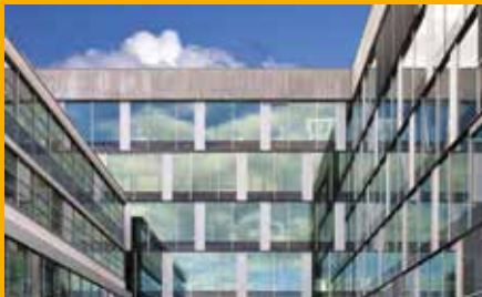
Kleben und Dichten im Fassadenbereich
