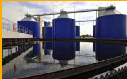
Schutz und Instandsetzung von Beton
