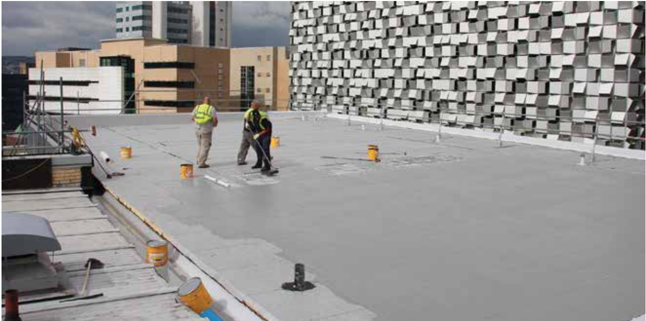
Abdichtungsbahn aus Flüssigkunststoff, Universität Hallam, Sheffield, Großbritannien
