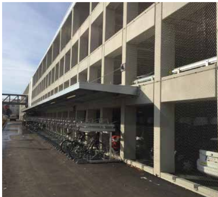
Bild 7: Der Doppelstock-Radständer bietet Platz für 160 Fahrräder
