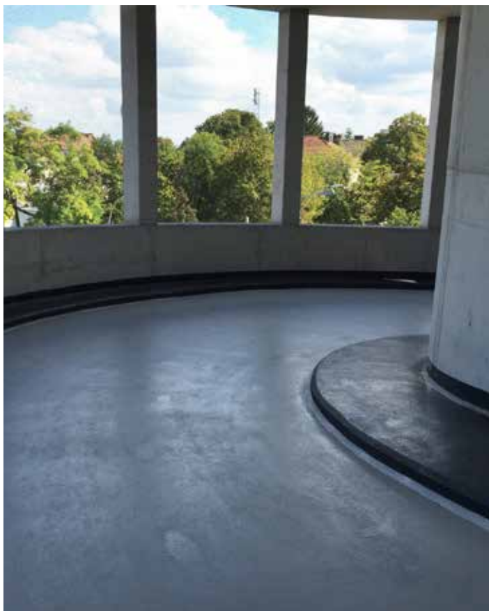
Bild 2: Über Rampen sind die vier Parkebenen verbunden
