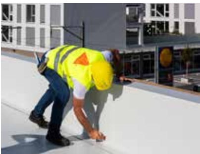
4. Die Bahn mit einer geeigneten Walze in die Position andrücken
