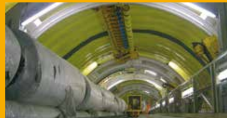
TUNNELBAU UND BAUWERKSABDICHTUNG
