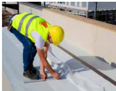
2. Die Position auf der oberen Hochzugkante markieren
