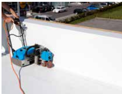
5. Abschließend die Naht mit Heißluft verschweißen
