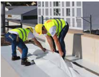
1. Schutzfolie von Sarnafil® AT FSA P entfernen
