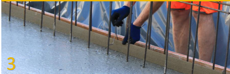
Fixieren mit Haltebügel für die folgenden Arbeitsschritte
