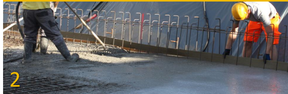
Einstecken des Fugenbandes in den Frischbeton
