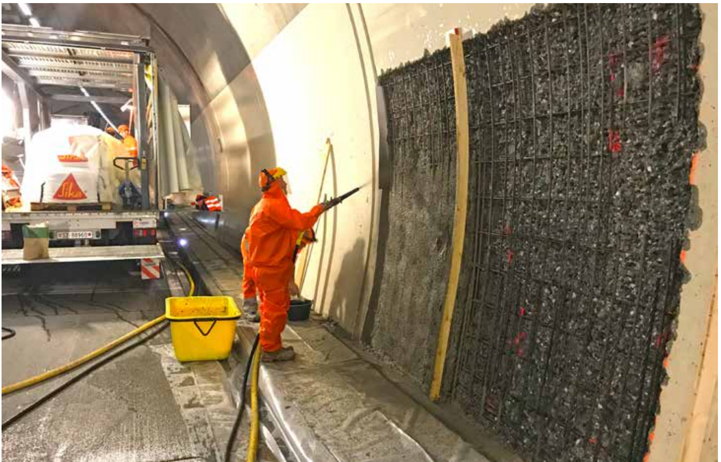
Spritzapplikation des Instandsetzungsmörtels Sika MonoTop®-422 PCC
