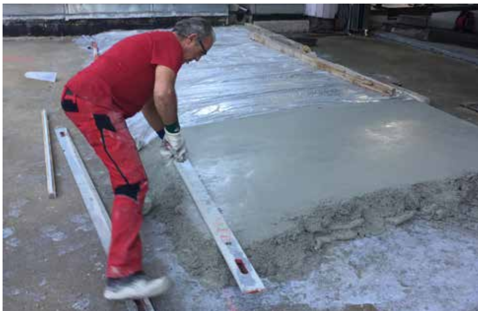
Der Niveausgleich erfolgte mit den Produkten SikaScreed®-20 EBB und SikaScreed® HardTop-70.
