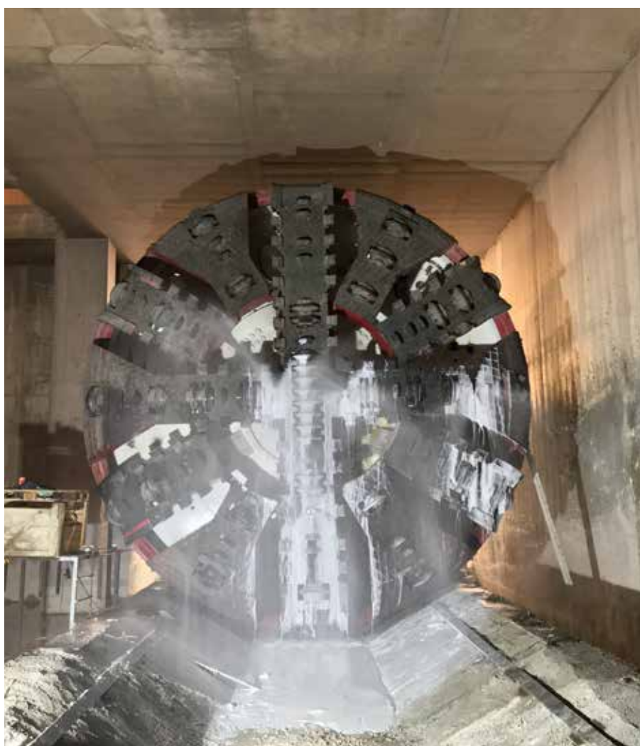
Tunnelbohrmaschinen spielen im Tunnelbau eine wichtige Rolle
