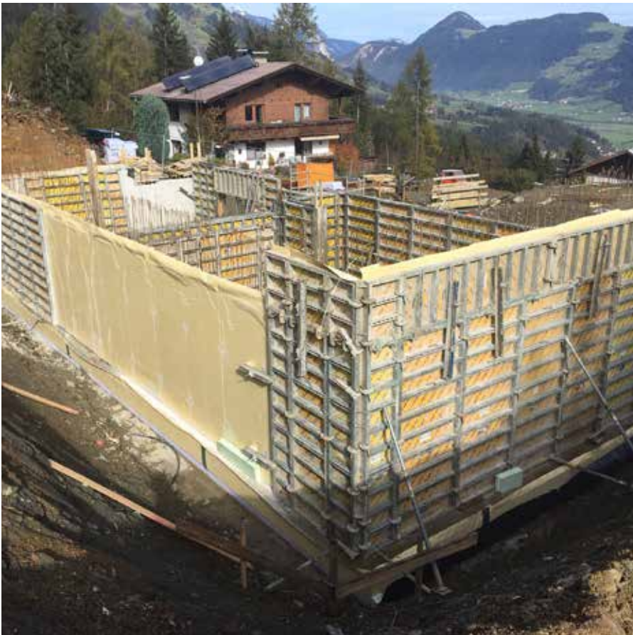
Vollflächige Abdichtung der Außenwände mit SikaProof® A
