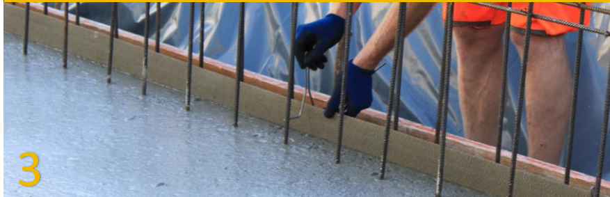
Fixieren mit Haltebügel für die folgenden Arbeitsschritte
