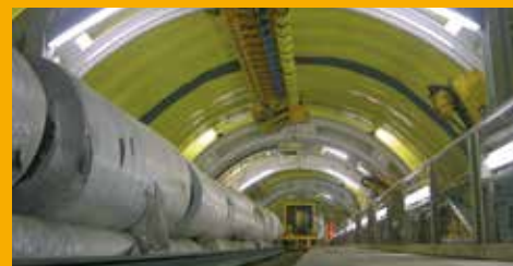
TUNNELBAU UND BAUWERKSABDICHTUNG
