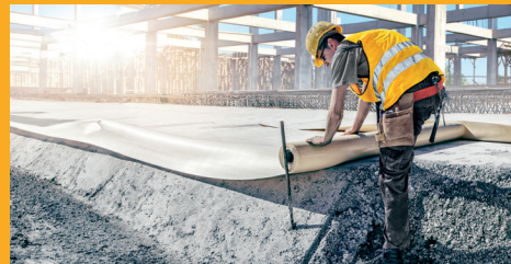
TUNNELBAU UND BAUWERKSABDICHTUNG
