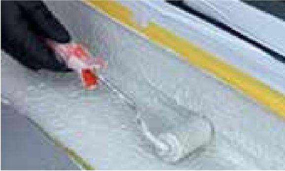
Vor dem Auftrag der 2. Schicht müssen aufstehende Fasern entfernt werden (z.B. überstreichen, schleifen, schneiden); Löcher oder freiliegende Bereiche nochmals mit Sikalastic®-625 N überstreichen.
