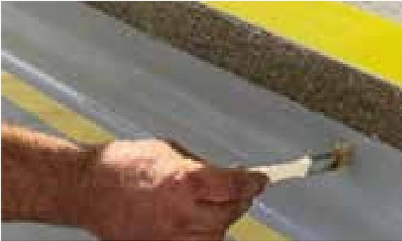
Sikalastic® Primer FPO mit einem Roller (Schaumstoffwalze empfohlen) gemäss Verbrauch aus der Primer-Tabelle auf die Abdichtung auftragen. Darauf achten, dass der Auftrag gleichmässig und vollflächig erfolgt.
