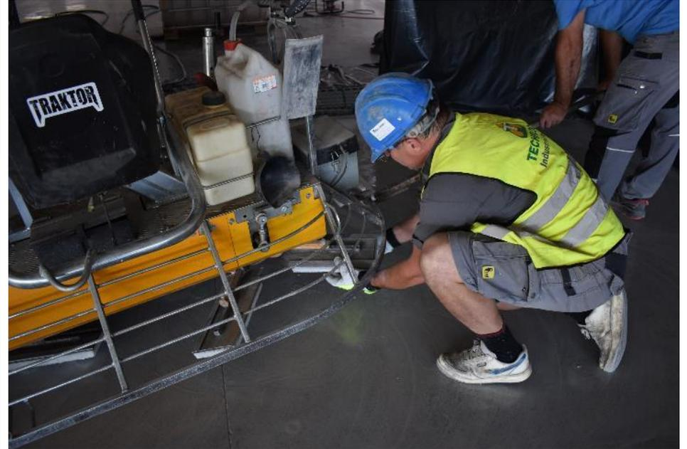
Einfacher Wechsel der Werkzeuge durch Haftpads
