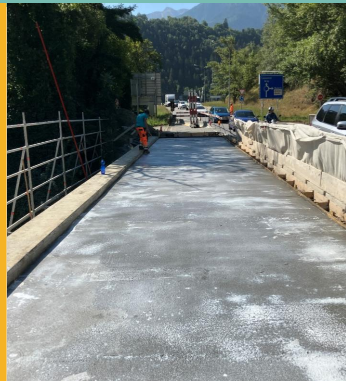
Brückentragwerk nach UHFB-Applikation
