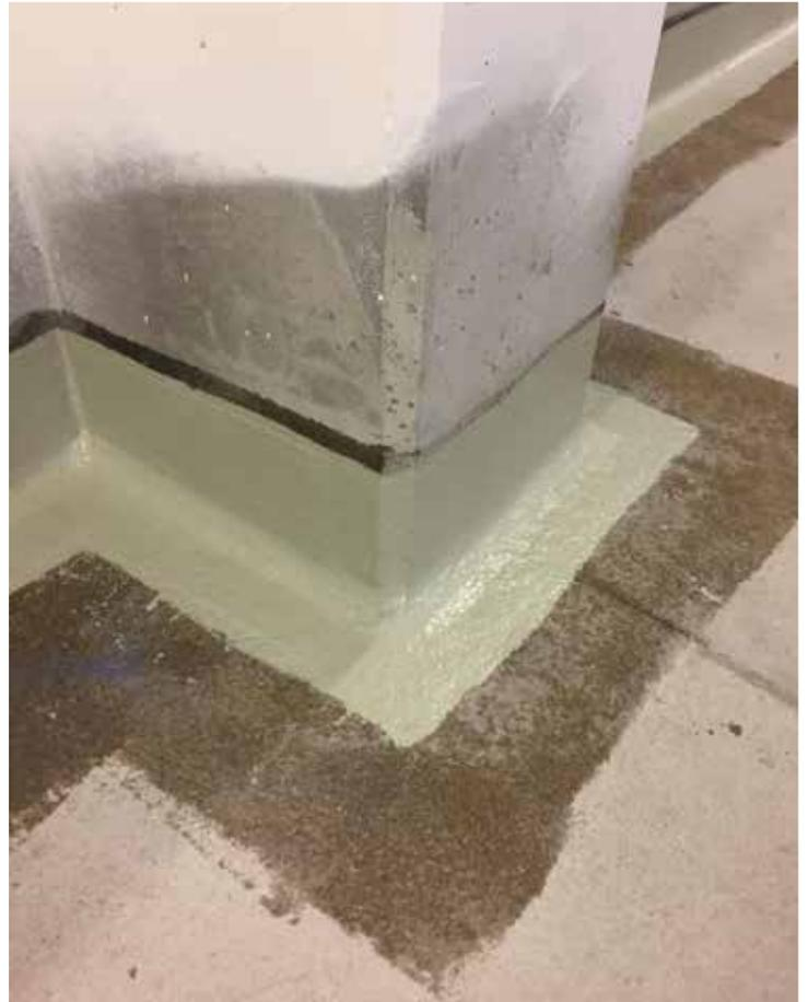
Bild 3: Hochzüge und Ecken werden mit einer nach ETAG 005 geprüften Flüssigkunststoffabdichtung mit Gewebeeinlage hergestellt
