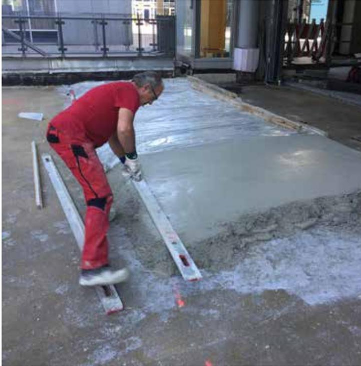
Bild 8: Niveauegleich mit SikaScreed®-20 EBB und SikaScreed® HardTop-70
