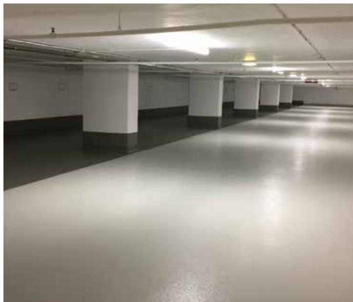
Bild 5: Die farbige Kopfversiegelung kennzeichnet die Bereiche
