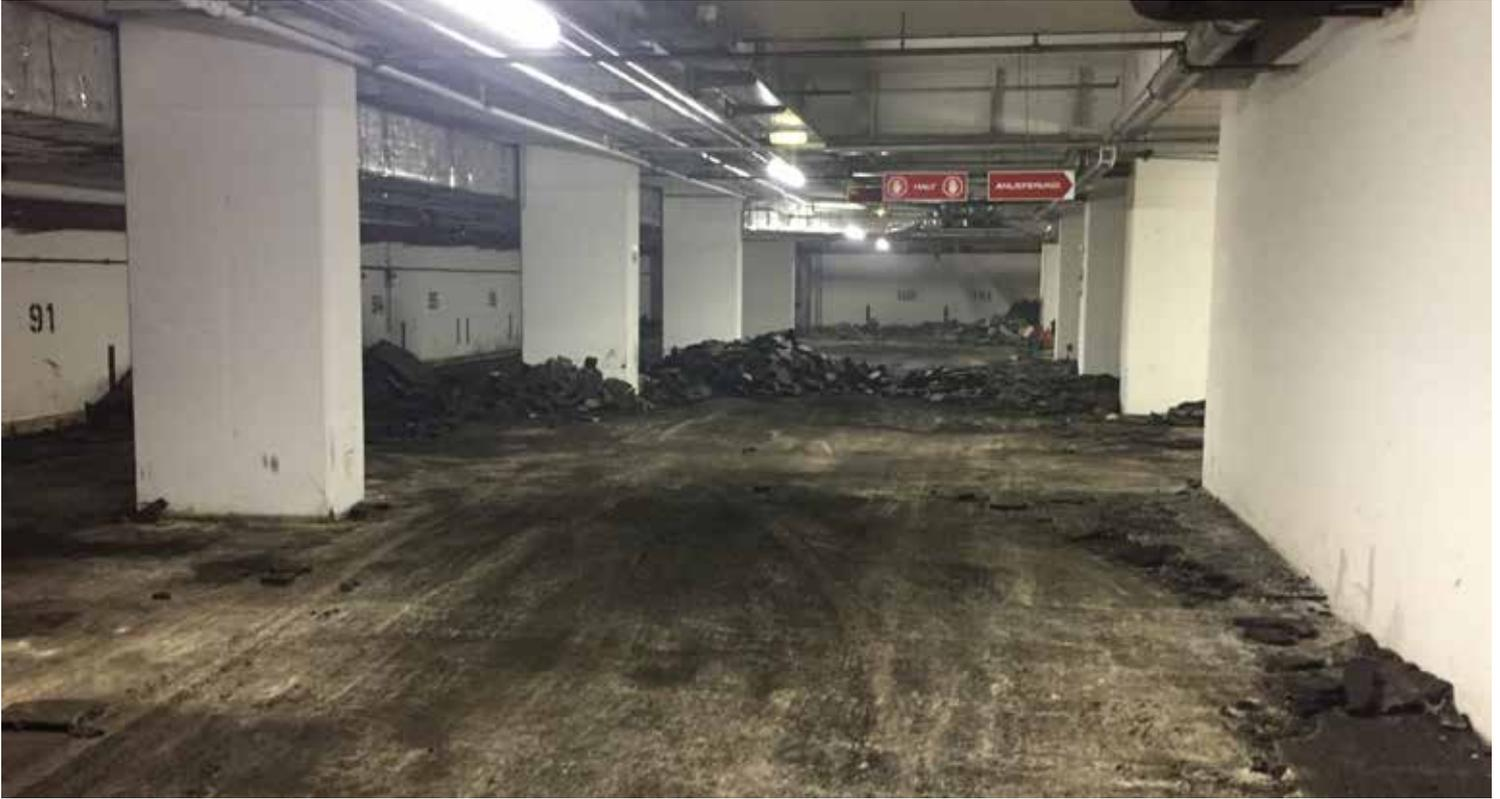
Bild 1: Abbruch des alten Asphaltbelages
