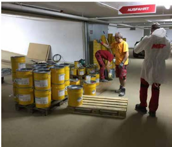
Bild 4: Einrichtung des Mischplatzes für die Sikafloor® Beschichtung
