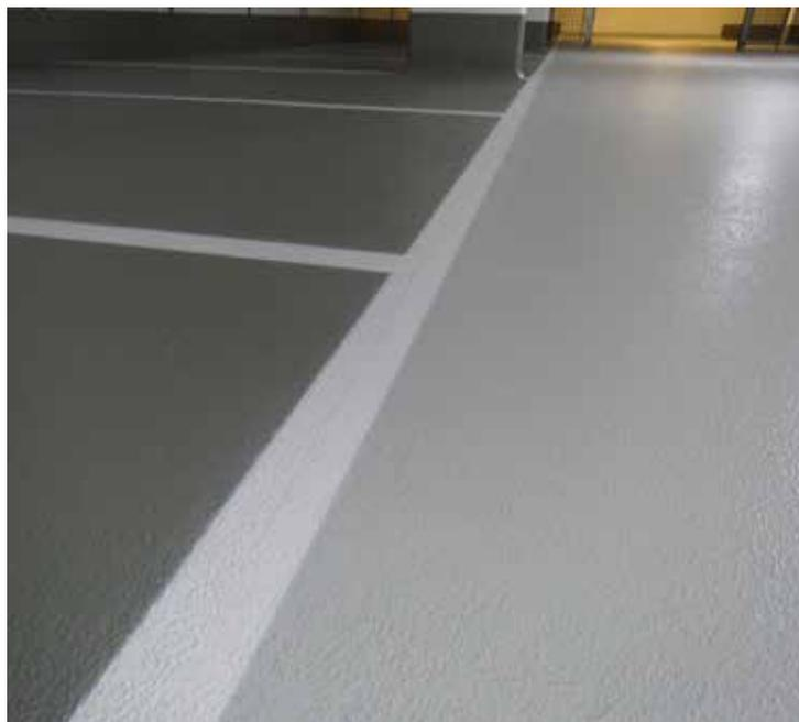
Bild 6: Im System abgestimmte Stellplatzmarkierung
