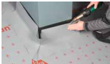
Sikaplan® MTP Eckanschluss universal fixieren.
