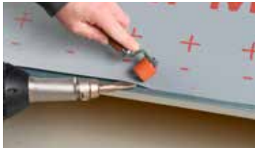
Sikaplan® MTP-340 auf SikaRoof® Tape 60 Weld aufschweißen.
