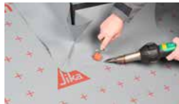
Sikaplan® MTP Eckanschluss universal mit der Unterdachbahn verschweißen.
