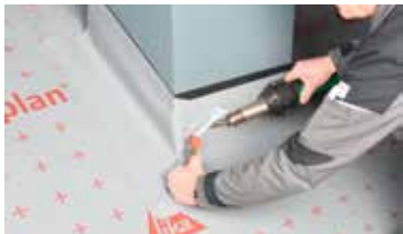
Die Ecke umbiegen und verschweißen.
