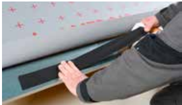
SikaRoof® Tape 60 Weld auf das Blech kleben.
