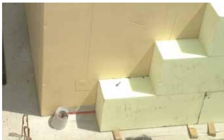
Bild 4: Frischbetonverbundfolie, Wärmedämmung und Sikadur® Combiflex SG
