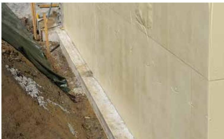
Bild 3: Außenwand nach dem Ausschalen
