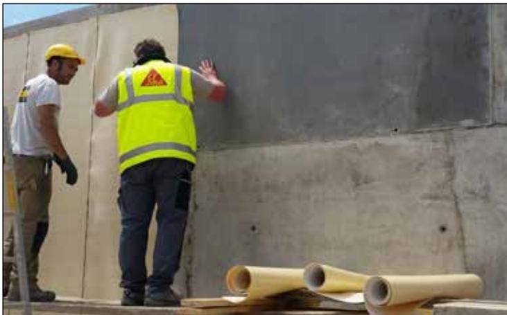
Bild 1: Befestigung der Frischbetonverbundfolie SikaProof® A an der Schalhaut
