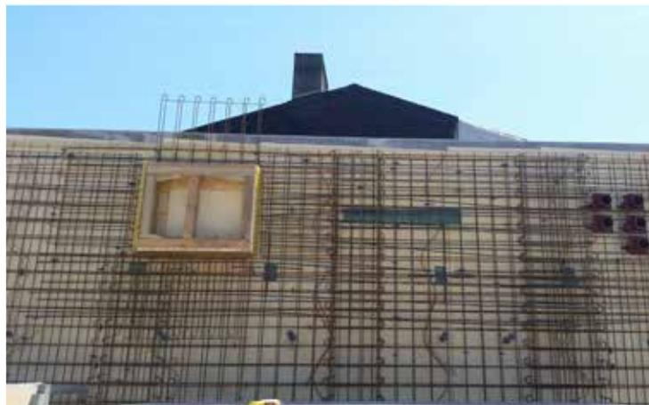
Bild 2: Frischbetonverbundfolie, Bewehrung, Wänddurchbrüche
