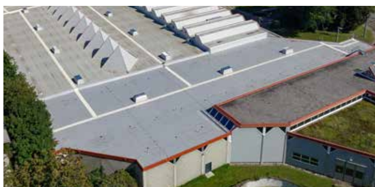
Bild 3: Schnelle und einfache Abdichtung von Details durch hohe Flexibilität des Materials
