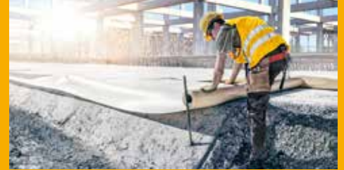
TUNNELBAU UND BAUWERKSABDICHTUNG
