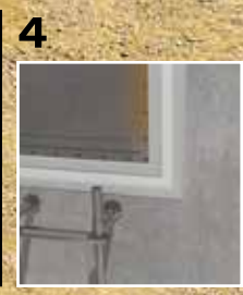
Anschlussfugen Beton-Stahl
