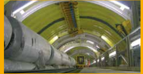
TUNNELBAU UND BAUWERKSABDICHTUNG
