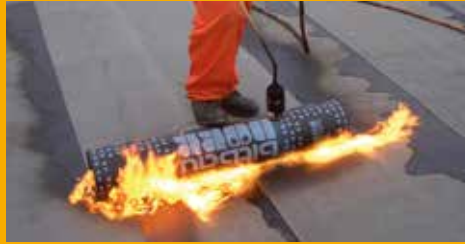
BITUMENABDICHTUNG
