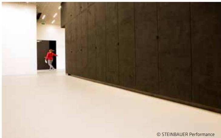
Bild 2 - Leichte Reinigung durch fugenlose Bodenbeschichtung
