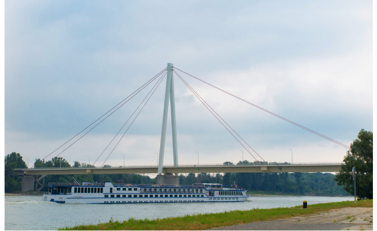
Bild 2 - Andreas Maurer-Brücke mit einer Spannweite von 228 m
