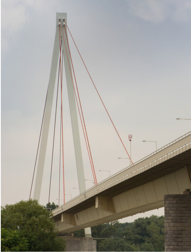
Bild 1 - Schrägseilbrücke mit 77 Meter hohen Pylon
