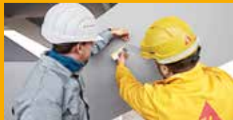
SERVICE UND BERATUNG AUF DER BAUSTELLE
