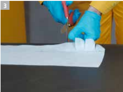
3 Zuschnitte Sikalastic® Rapid Vlies-110 vorbereiten.
