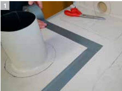
1 Abzudichtenden Bereich mit Klebeband abgrenzen.
