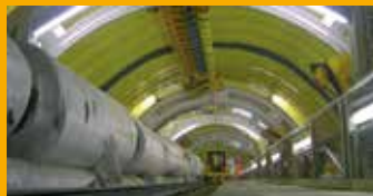
TUNNELBAU UND BAUWERKSABDICHTUNG
